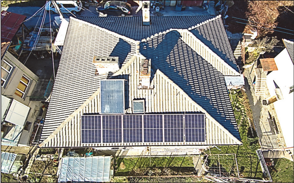
Фиг. 5. Фотоволтаична електрическа централа (ФЕЦ).
