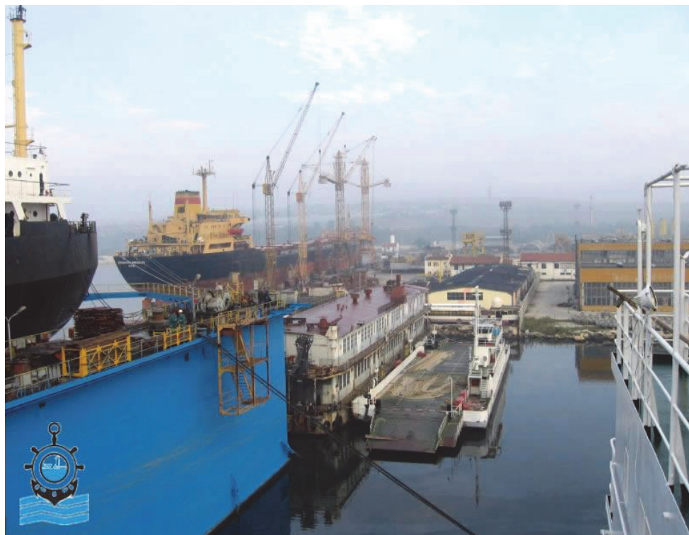
Фиг. 2. Подготовка за ремонт на кораба
