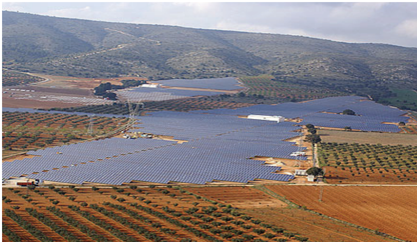
Фиг. 9. Фотоволтаична централа с фиксирана поддържаща конструкция намираща се в Испания
