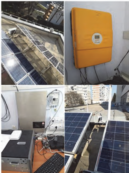
Фиг. 1. Компоненти на микро PV
