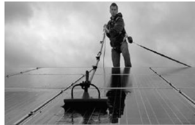
Фиг. 3. Стандартни методи за почистване на фотоволтаици
