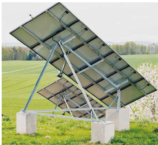
Фиг. 4. Едноосна следяща система
