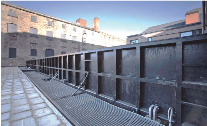
Фиг. 9. Барieri, издигащи се от хоризонтално във вертикално положение
